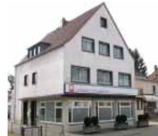
Gemeindepshychiatrisches Zentrum Griesheim Wilhelm-Leuschner-Straße 101, 64347 Griesheim Tel: 0 61 55 - 86 83 77 0 gpz.griesheim@caritas-darmstadt.de
